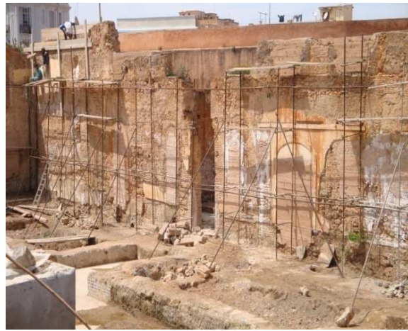
Photo n°21: Restauration du Mechouar Source : Idem.
