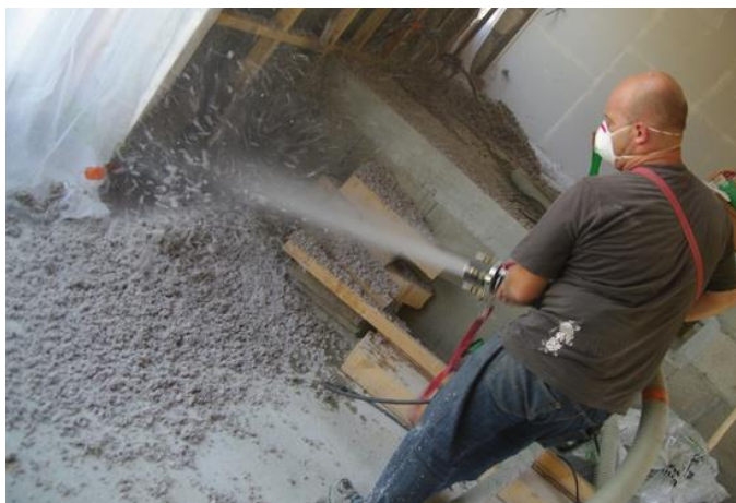
Figure 84 : un nouveau type de pose d'isolations thermique et acoustique par projection
