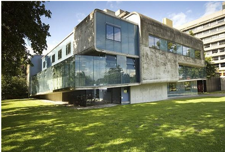
Figure 16: Vue d'extérieur du centre.
