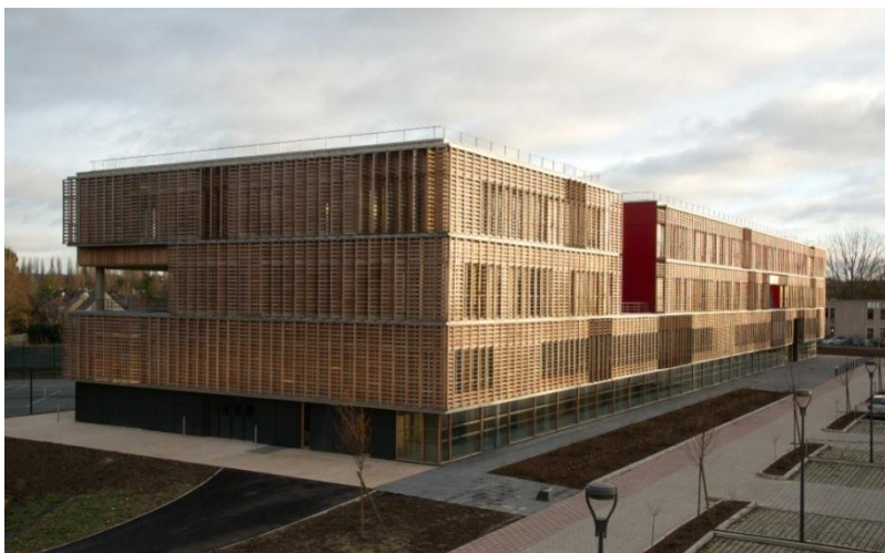
Figure 12: Vue d'extérieur du centre.
