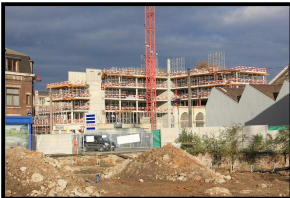
Centre CMI, chantier novembre 2012
