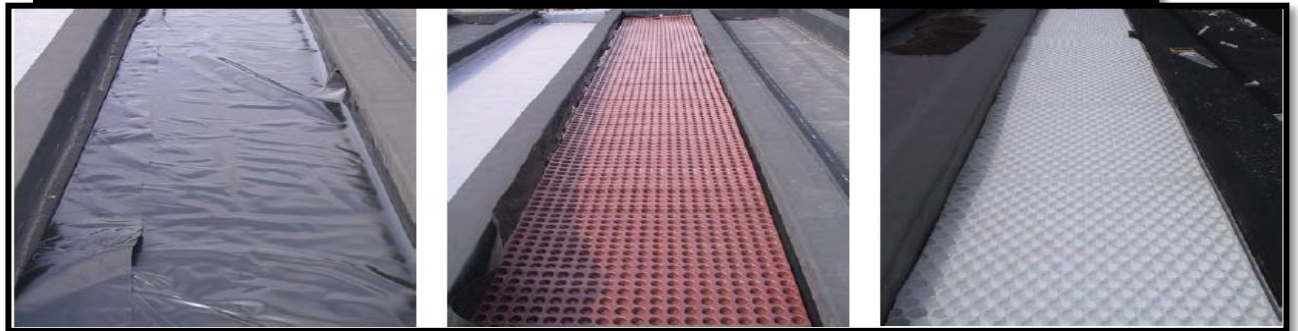
Pose d'un film polyéthylène
