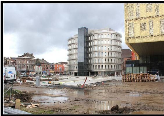
La Cité administrative, chantier février 2014
