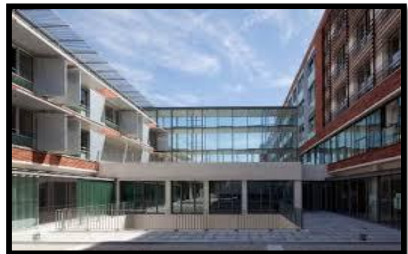
Figure 20. Hôpital Rothschild (Passerelle intérieur)
