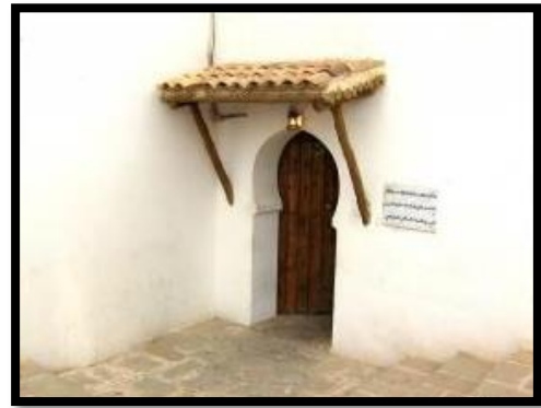
Figure 11 : façade cote de la grande mosquée. (Source : Auteur)
