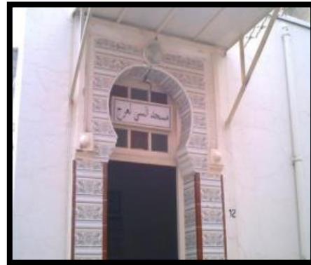
Figure 8 : Mouçalla Si Laaraj. (Source : Auteur)
