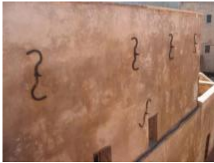
Figure 57: La Prison, Citadelle d'El Mechouar (source: auteur)
