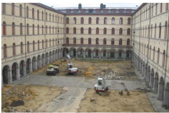
Figure 31: Le projet en chantier
