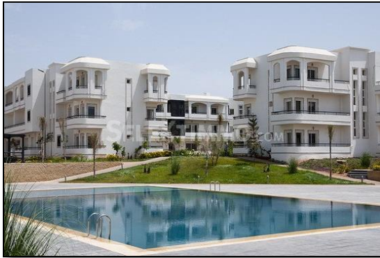
Figure II.30 : Vue extérieure des logements
