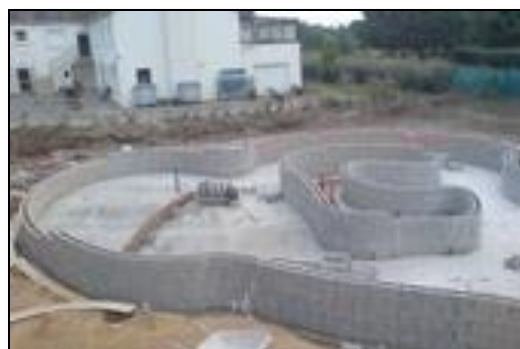
Figure VL15 : Piscine avec structure en béton armé.
