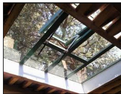
Figure VI12: Exemple de verrière à ouverture
