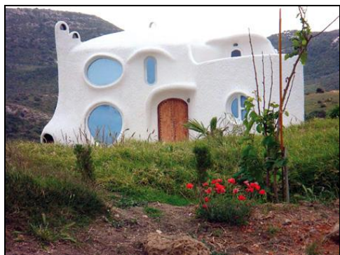
Figure II.59 : La façade des bungalows
