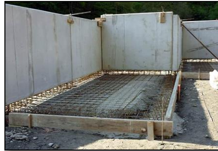
Figure VI1 : Système constructif en béton armé.
