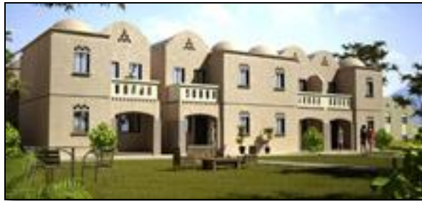
Figure II.47 : façade principale des logements
