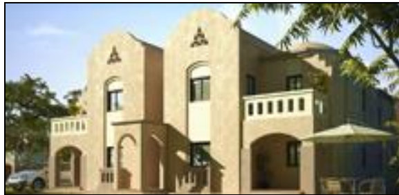
Figure II.48 : façade secondaire des logements
