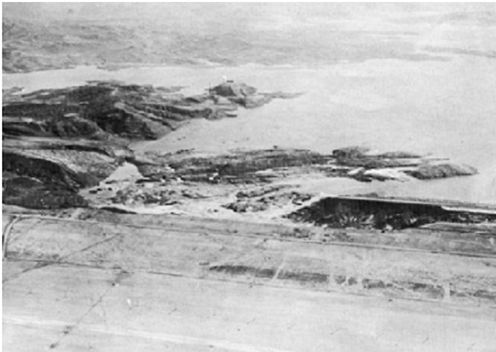
Figure 3. 2 : Vue aérienne de la rupture de barrage de Fort Peck (corps de l'armée des États-Unis d'Ingénieurs, 1939, ( Mike Jefferies et Ken Been, 2006)
