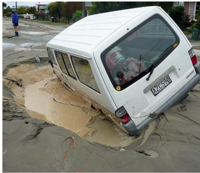
Figure 3. 10 : Une camionnette conduit dans un trou causé par la liquéfaction, (Christchurch (2011))
