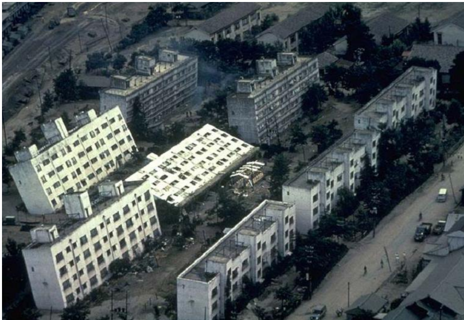
Figure 3. 3 : Inclinaison des bâtiments d'appartements de Kawagishi-cho à Niigata au Japon dues à la chute de la capacité portante du sol par liquéfaction ( Peter M. Byrne et al, 2008).
