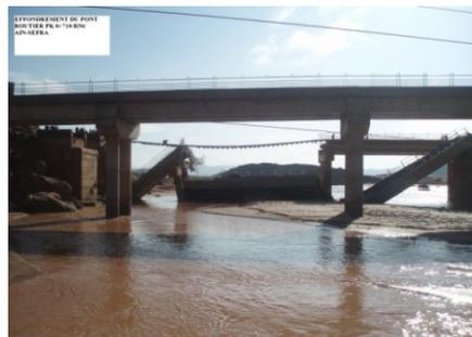
**Figure 2.7** Exemple d'effondrement d'un pont à Beniounif
