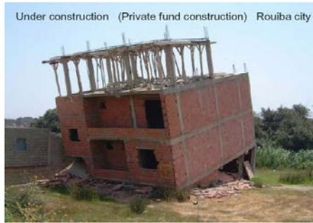
**Figure 2.8** Exemple d'effondrement d'une maison lors du séisme de Boumerdès
