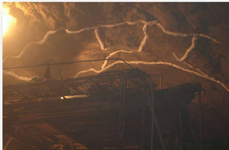
Figure 3.34 Système de collecte d'eau installé en site (Li et al., 2009)
