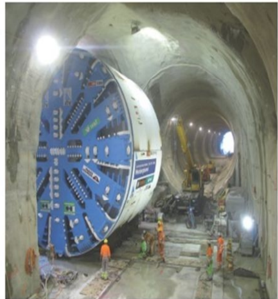
Photo 6 : Transformation du tunnelier au tunnel de Weinberg / Umbau Hydroschild beim Weinbergtunnel
