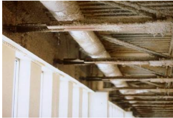
Figure 4.27 : Amortisseur viscoélastique solide (WTC, N.Y) [6, 35]
