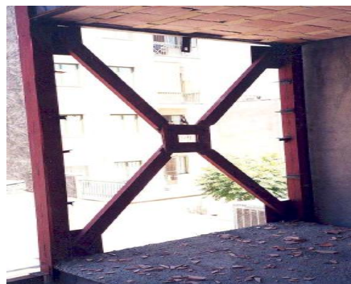
Figure 4.22 : Amortisseur de Pall [6]
