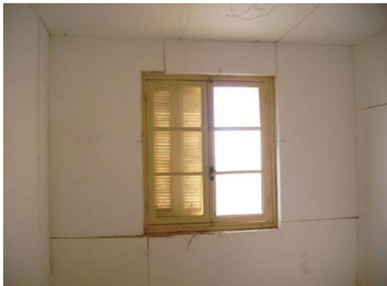
Fig.(3.26): Surface intérieure du mur Sud.
