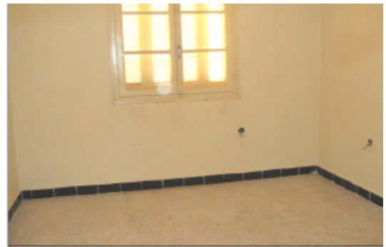
Fig.(3.5): Photo de la face Sud de la pièce sans isolation.
