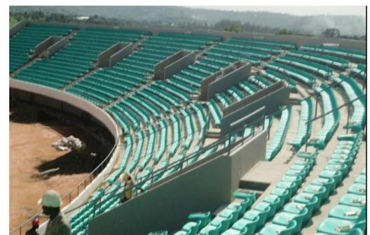
Figure 60 : exemple de gradins circulaires en béton
