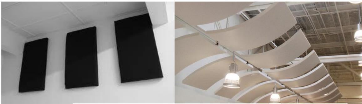
**Figure 91:** Exemples des absorbants et réflecteurs acoustiques
