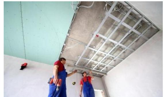
Figure 79: faux plafond hydrofuge
