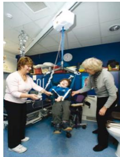
Figure 3-40 : palans montés au plafond
