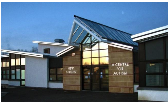
Figure 1.9 : façade principale du centre
