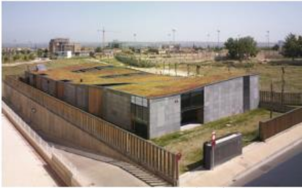
Figure 1.27: Exemple de toiture végétalisée et de mur masse, Oliver Kindergarten (source: archdaily.com)
