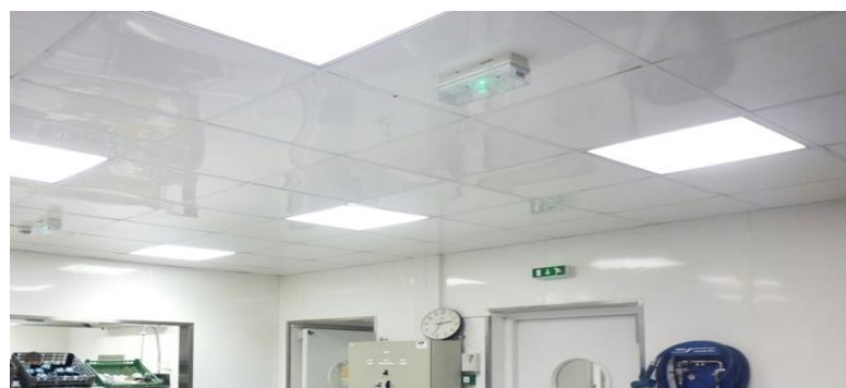
Figure 3-15: plafonds homogènes avec ferrures d'éclairage encastrés
