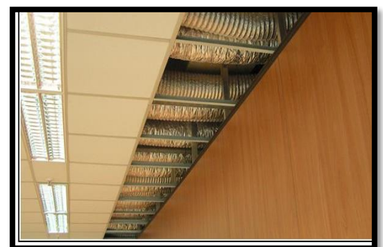
Figure 3-13 : Passage des gaines
