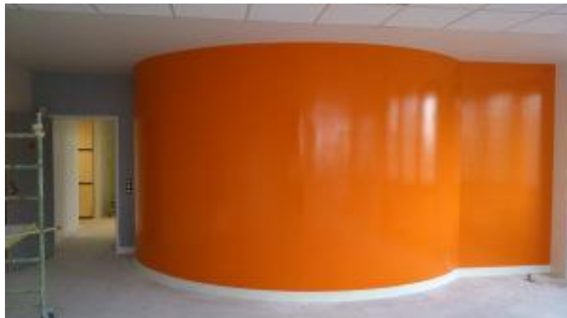
Figure 3-19: Mur en BA 13
