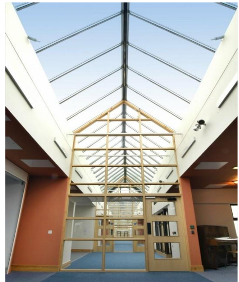
Figure 1.10: Le toit 'aile de mouette' utilisé dans le centre
