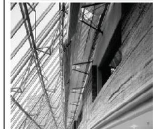
L'ossature est encre au sommet du mur en pisé, charge répartie uniformément par un chaînage en béton armé
