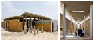
La structure en béton est indépendante des murs en terre, aucune liaison apparente.
