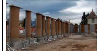
Les baie sont des parties indépendantes des trumeaux en terre et on ne réalise pas de percement,
