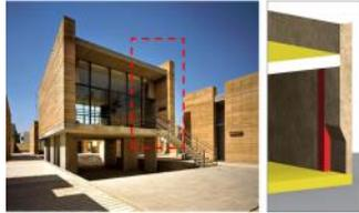
Le poteau en béton est encastré dans le mur en pisé et reprend les charge de la dalle pleine. Le pisé est seulement un remplissage à la structure en béton armé
