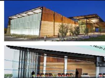
La charpente qui recouvre la bibliothèque repose sur des mur en pisé tronqués avec des sommet en acier qui les protège des intempéries
