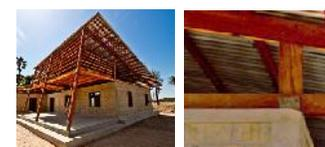
Les charges de la charpente Bois-Tôle galvanisé sont transmises par un chaînage en béton et un ancrage en acier
