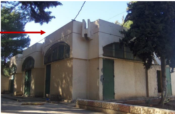
Figure 55: bungalows Source : photo prise par auteur
