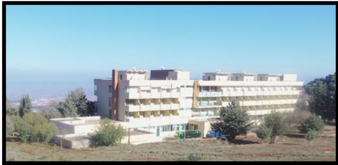
Figure 35: sanatorium Source : Photo prise par l'auteur
