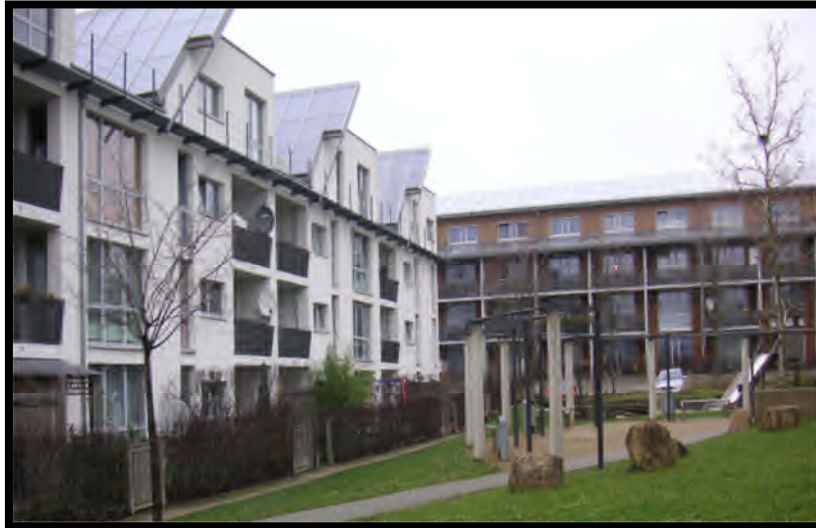
Figure 53. Capteurs photovoltaïques. Source 81
