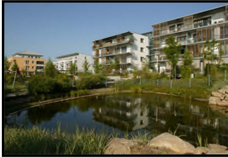
Figure 54. Bassin de rétention dans une cours intérieur. Source 82
