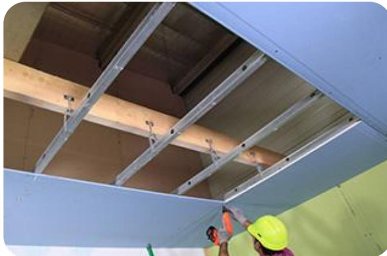
Figure 75: photo de mise en place des faux plafonds
