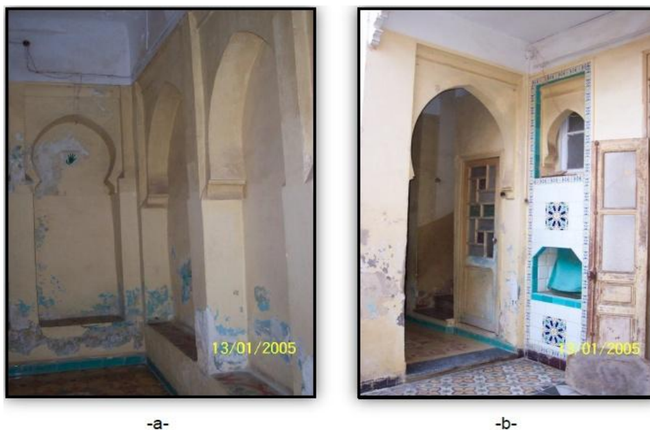
Figure 20 : le vestibule d'une maison traditionnelle à Derb Hlawa ; -a- Dekkanet décorées par des arcades brisée outrepassées ; - b- l'entrée en chicane Source : DIDI Ilies. 72
