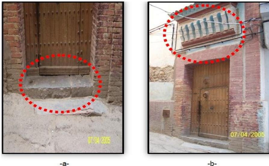
Figure 19 : une entrée principale d'une maison traditionnelle à derb hlawa, -a- : le seuil ou l'atba, -b- qbu au dessus de la porte massive de bois.
