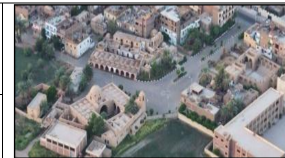
Figure 32 : vue aérienne du nouveau Gourn
