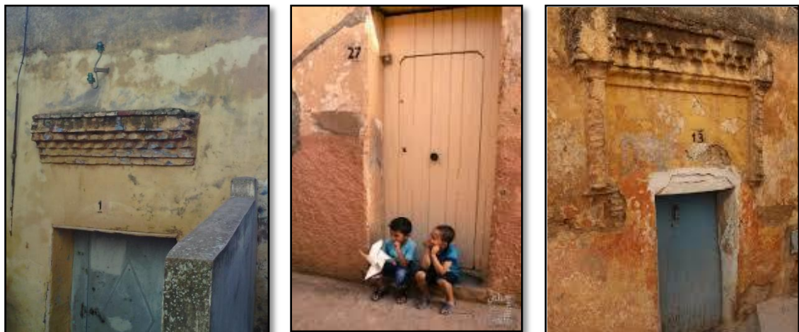
Figure 71 : traitement de l'entrée via un auvent qui la surmonte ou une porte inscrite dans une autre plus grande qui forme le cadre de l'accès. (Source : Auteurs)
