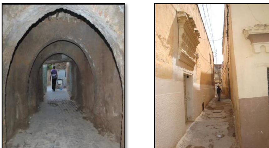
Figure 18 : des photos de derb à la médina de Tlemcen Source : DIDI Ilies. 67
