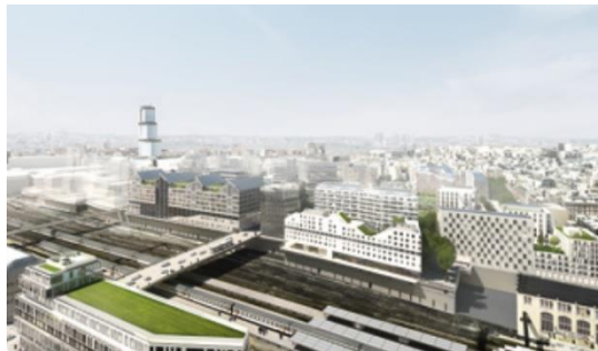
Figure 46: côté faisceau Saint-Lazare
