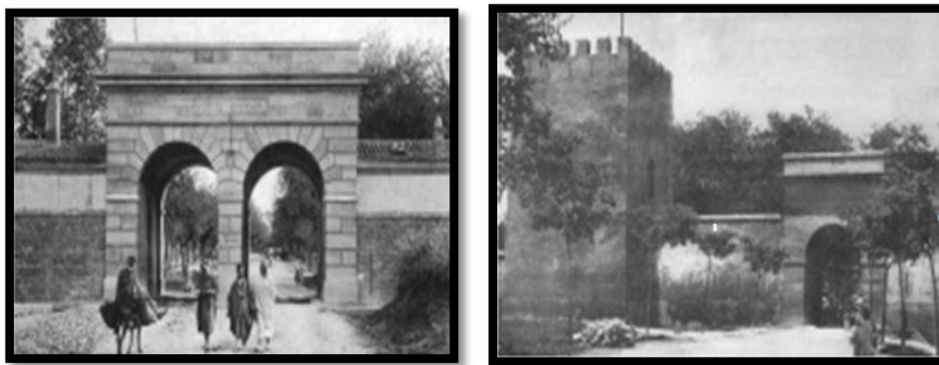
Figure (21) : la porte d'Oran (gauche) et la porte des carrières (droite)
