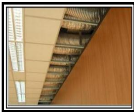
Figure (130): un faux plafond
