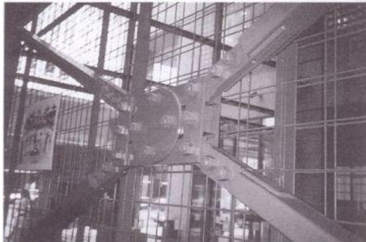
Figure 1.6 : Amortisseurs à frottement
