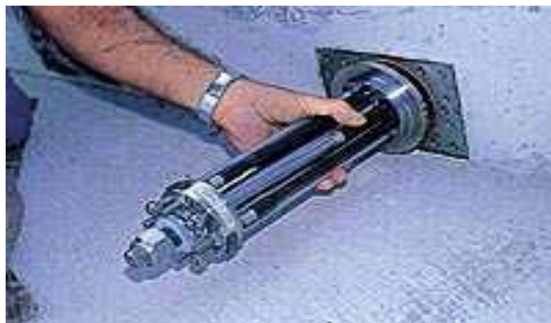
Figure 1.10 : Renforts antisismiques réalisés avec des AMF.
