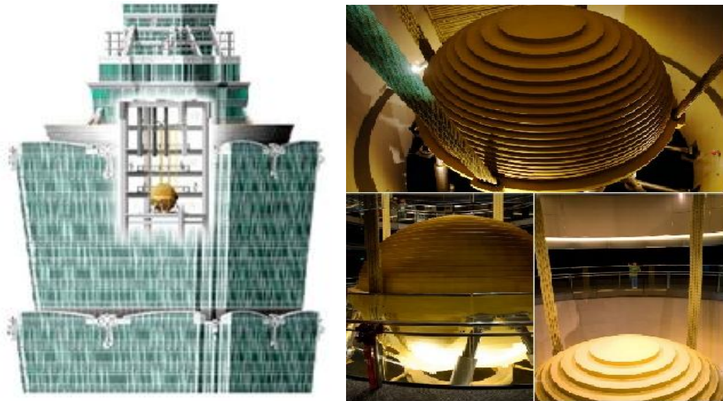
Figure 1.7 : Un TMD pendulaire de 800 tonnes dans un bâtiment de 508 m de hauteur (tour de Taipei 101)
