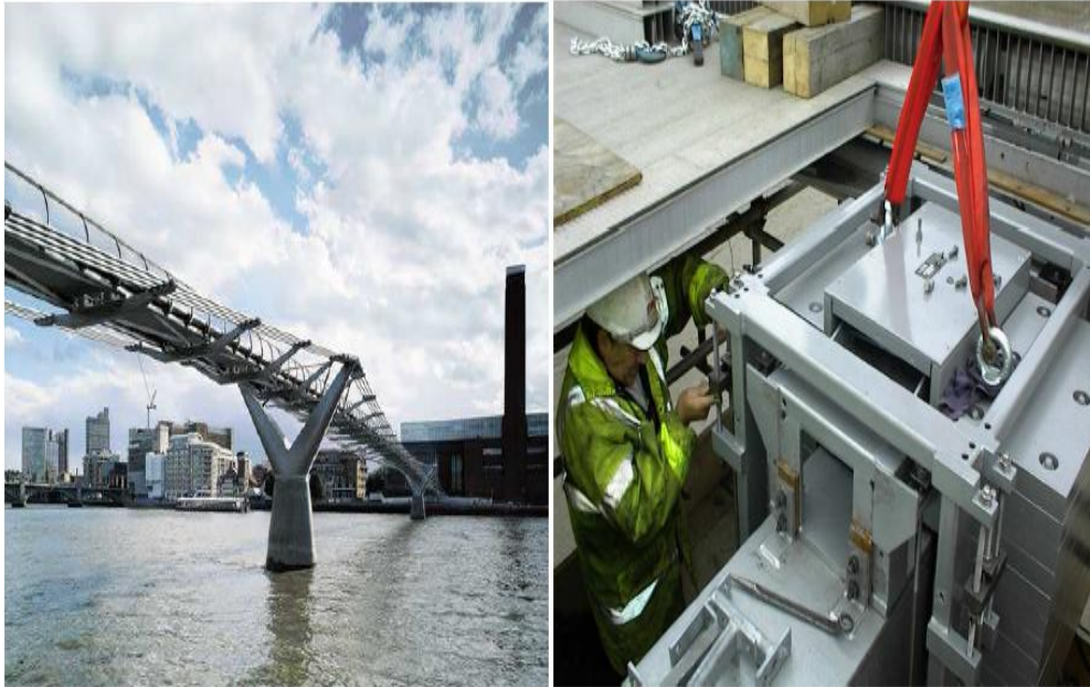
Figure 1.13 : Le pont du Millenium, Londres, 2000 et à l'installation des TMD
