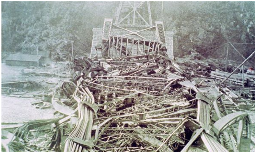
Photo I.1 : L'effondrement du pont de Québec 1907
