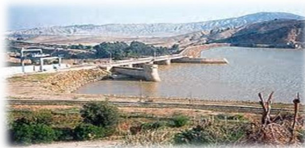
(c) Le barrage de Fergoug après reconstruction 1986.
