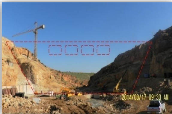
( a ) Vue en amont
