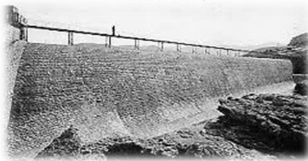
(a) Le barrage de Fergoug en 1907 avant la rupture.
