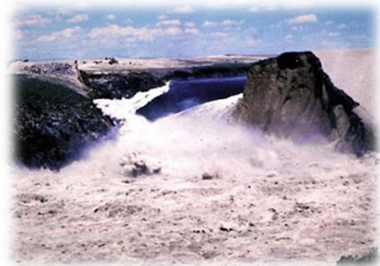
(b) Rupture du barrage de Teton (USA).
