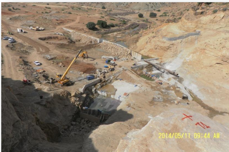
Figure 4.26. Bétonnage de la parie encrée des plots centraux du barrage voûte mince d'oued That Wilaya de MASCARA.
