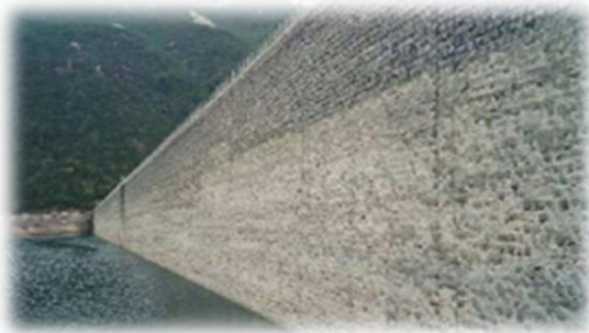
(a) Parement amont du barrage.
