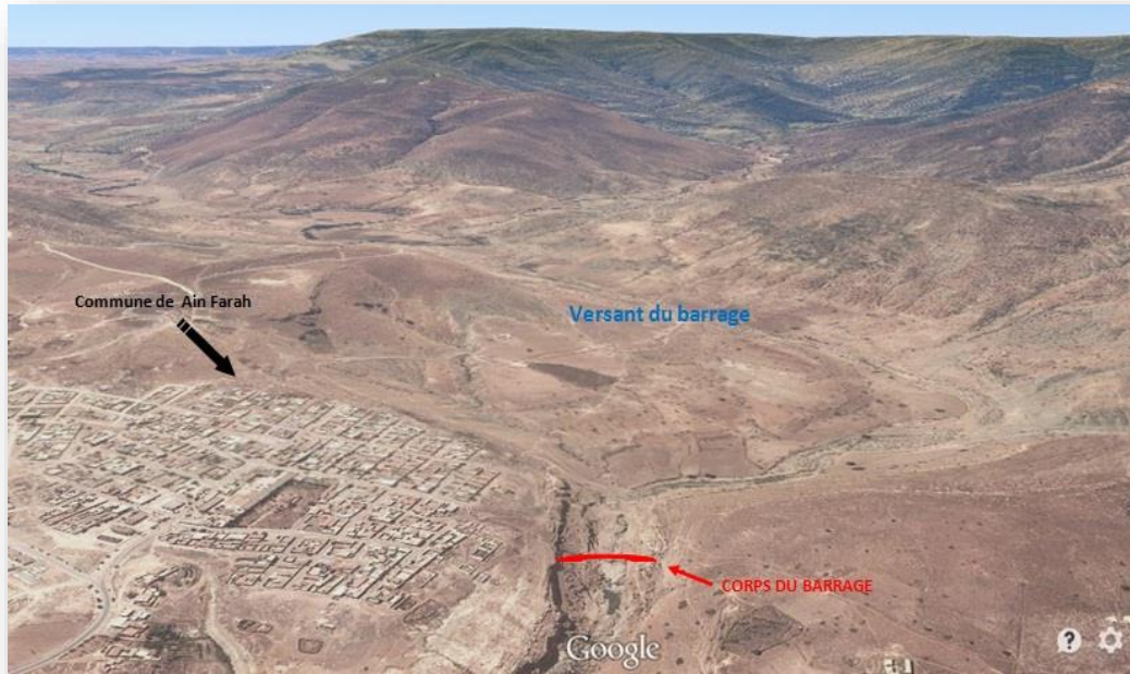
Figure 3.6. Versant du barrage Oued Taht (Google Maps, 2014)
