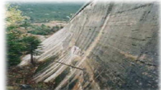
(b) Vue d'ensemble du parement aval.
