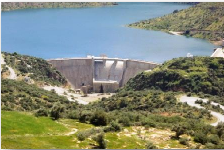
Figure 2.1. Barrage voûte de Tichi Haf Béjaïa (Algérie) mis en service en 2005. Sa hauteur est de 84 m. (Tiré de : www.aghaladh.centerblog.net )
