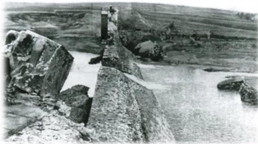
Figure 2.8. La rupture du barrage de Bouzey (Deroo L.,2011).
