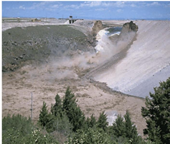
*Figure 1.13 : Rupture du barrage Teton en 1976.*
