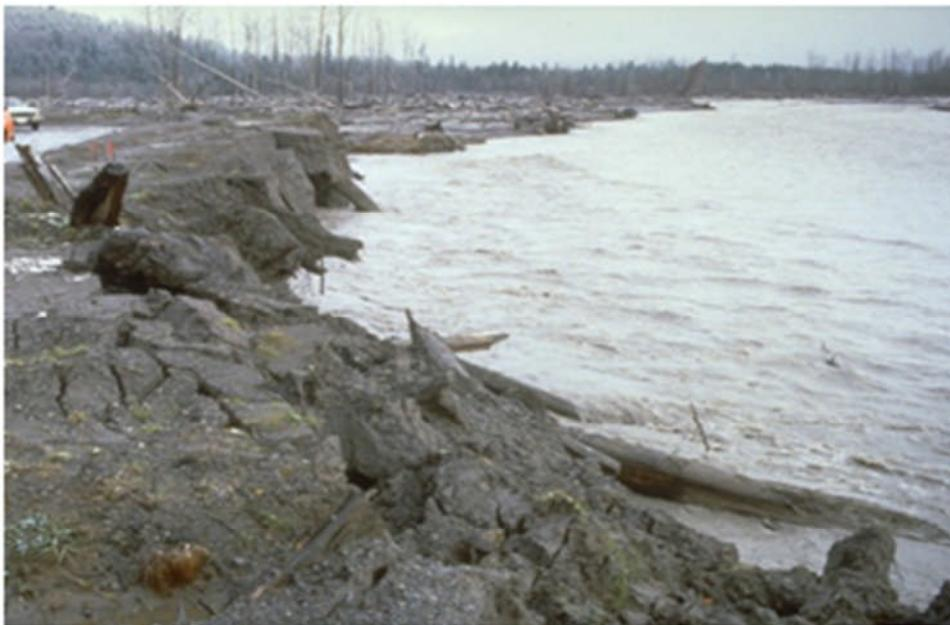
*Figure 1.10 : Affouillement d'une digue.*
