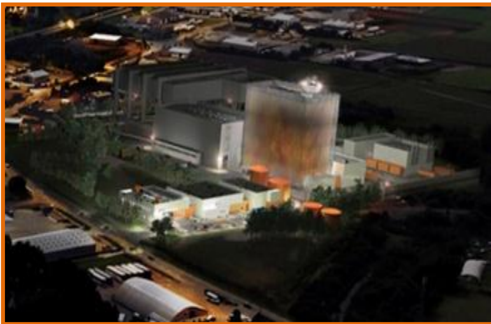
Figure 23 : Vue sur l'ensemble de la centrale de Landivisiau
