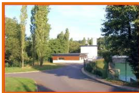
10) Poste de surveillance
