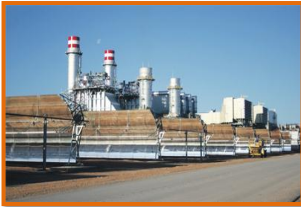
Figure 39 : Centrale à cycle combiné de Beni Mathar ( http://www.abengoa.es/web/es/noticias_y_publicaciones/noticias/historico/2014/12_diciembre/abg_20141215.html )
