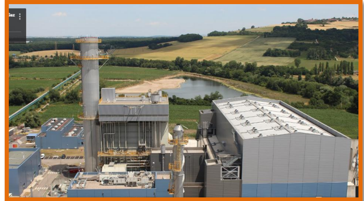
Figure 30 : la centrale de Blénod ( www.edf.fr/en/node/32769 )
