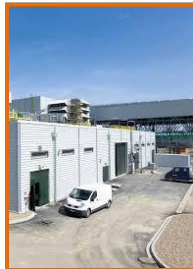
Figure 63 : Ateliers et magasins de la centrale de Bayet ( www.industcards.com/cc-france.htm )
