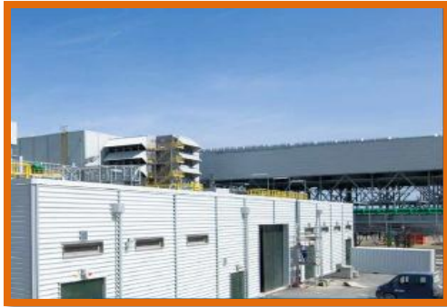
1) Salle de contrôle
