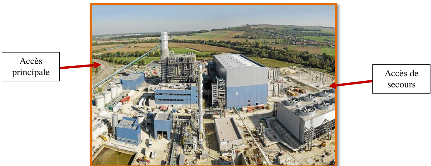
Figure 31: Vue d'ensemble sur la centrale de Blénod ( www.edf.fr/en/node/32769 )
