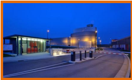
1- Poste de surveillance
