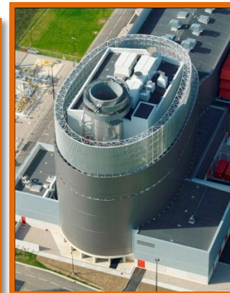
4- Générateur de vapeur
