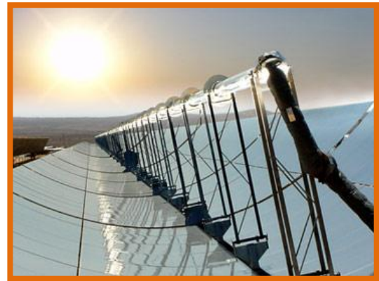
Figure 94 : récepteur d'un panneau solaire cylindro-parabolique
