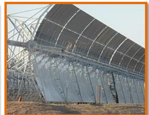
Figure 89: Panneaux solaires thermodynamiques en forme cylindro-parabolique ( https://fr.wikipedia.org/wiki/%C3%89nergie_solaire_aux_%C3%89tats-Unis )
