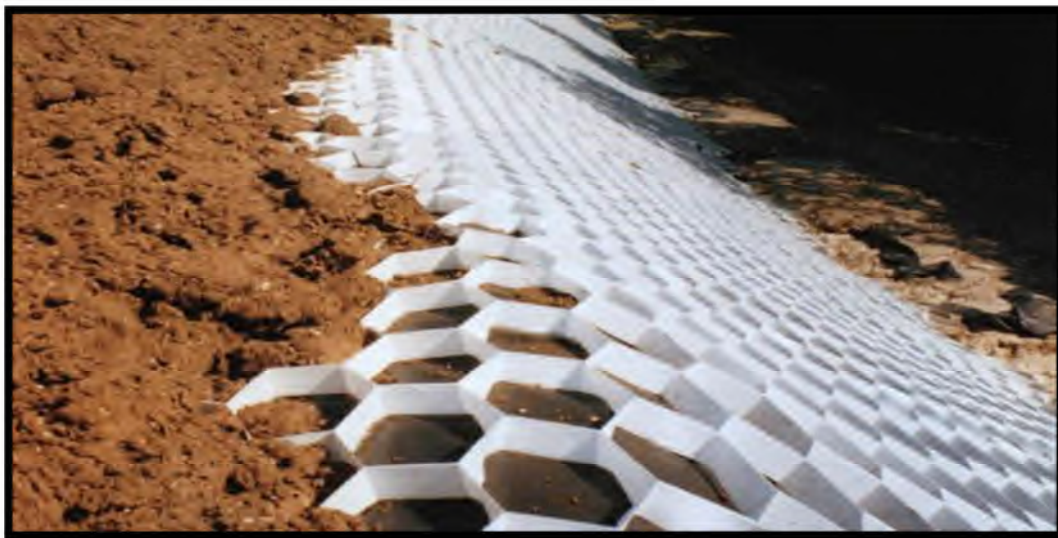
Figure 2.7 – Renforcement par géotextiles (Bouffoul K.,2005)
