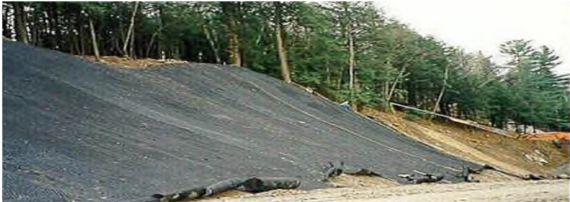
Figure 2.8 – Renforcement par géogrilles. (Boulfoul K.,2005)
