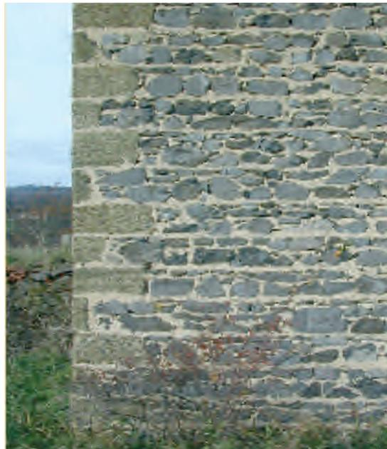
**Figure 1.4** : Maçonnerie mixte de granit et roches métamorphiques [manuel de sensibilisation maçonnerie, 2006]
