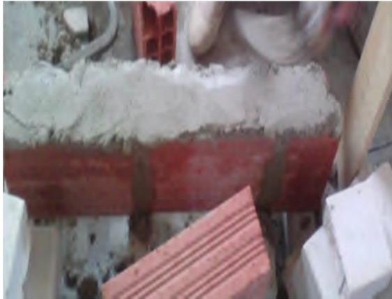
**Figure 3.20 :** Etalement du mortier
