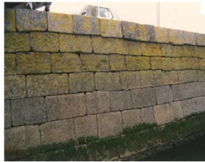
**Figure 1. 1** : Maçonnerie de pierres sèches [Laboratoire Régional de l'Equipement de Saint-Brieuc (LRSB), 1994]
