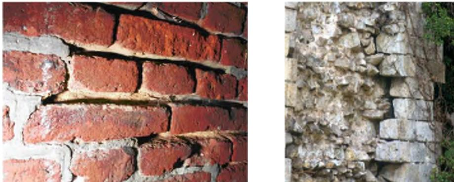
**Figure 1.5 :** Disjoints profonds et dislocation d'ouvrages en maçonnerie
