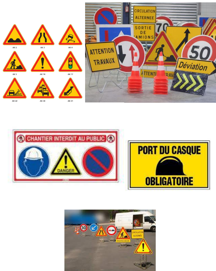
Figure.8.3 : Signalisation des chantiers.
