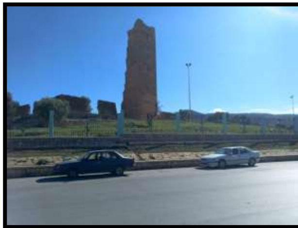
FIGURE 1: vue sur le minaret de Mansourah et son environnement .
