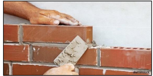
Figure 98: cloisons en maçonnerie
