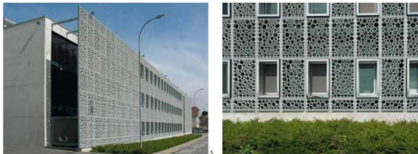
Figure 81 : le bâtiment Swatch à Cormondrèche, dans le canton de Neuchâtel
