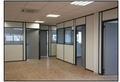
Figure 102: faux plafond en plaque hydrofuge
