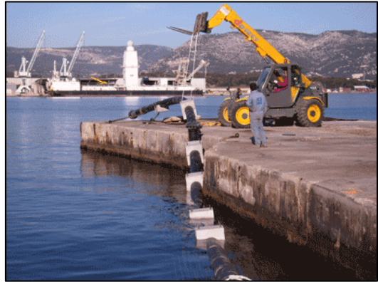
Figure 29: Pose de réseaux eau de mer
