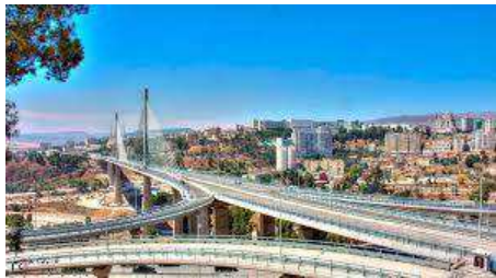
Figure 69 : Pont Salah bey
