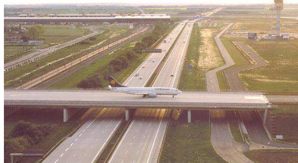
Figure 13 : Pont pour avions « aéroport en Allemagne Source : https://files1.structurae.de/files/photos/f004345/rollbruecke_ost.jpg
