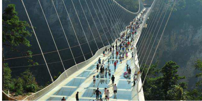
Figure 10 : le pont en verre de zhangjiajie en chine. Source : culturebox.francetvinfo.fr/arts/architecture/chine-le-pont-en-verre-
