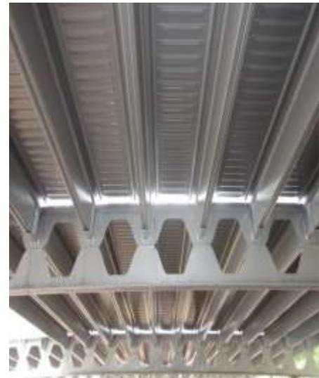
**Figure 58 :**Plancher collaborant acier béton<sup>2</sup>
