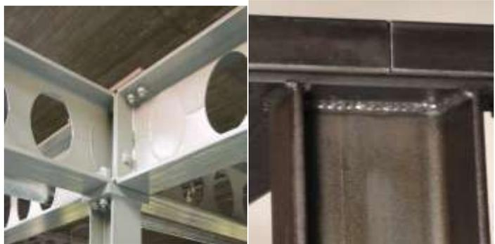
**Figure 54:** poutre alvéolaire
