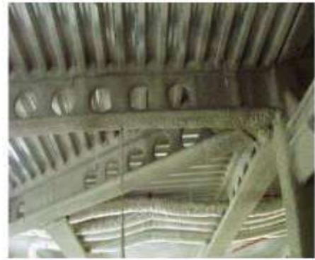
**Figure 57 :** protection par flocage d'une poutrelle ACB
