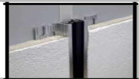
Figure 60: Détail couvre Joint de murs
