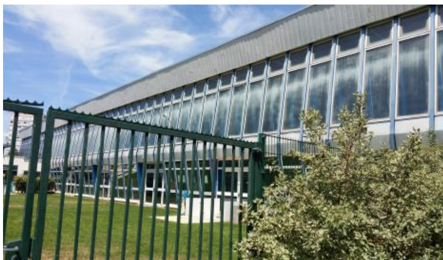
Figure 2.12 : Photo de la façade conservée (coté piscine)
