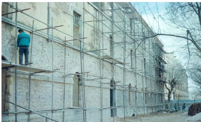
Figure 1.29 : Echafaudage de la façade pour rénover le mur extérieur
