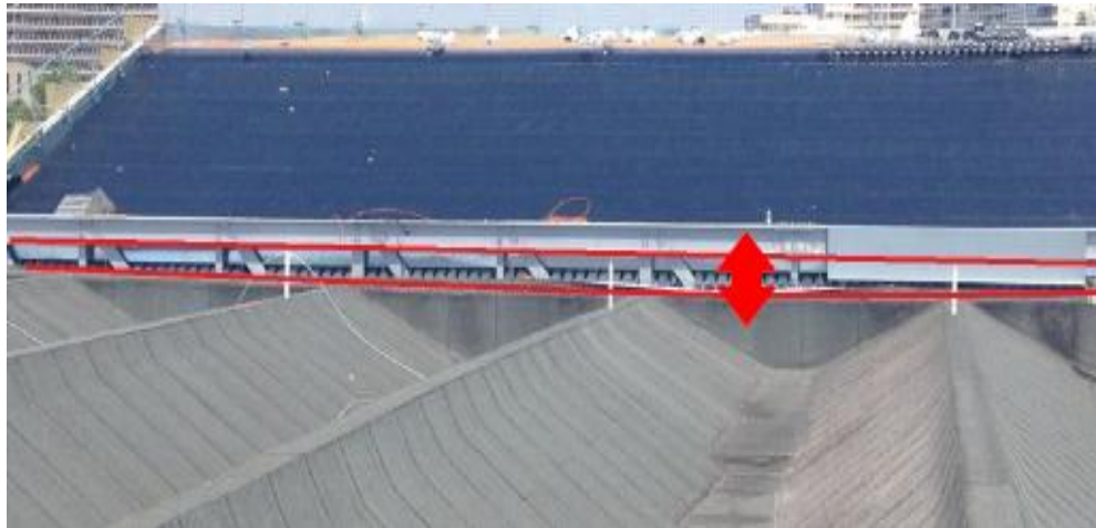
Figure 2.10 : Photo de la flèche prise par la toiture
