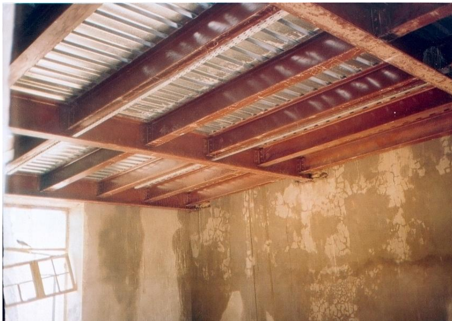
Figure 1.31 : Poutrelles métalliques reliées aux poutres
