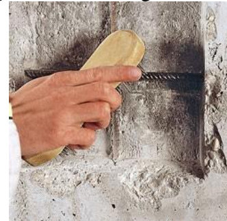
Figure 4.17: Élimination de la rouille
