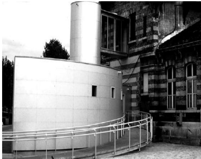
Figure 1.15 : Diversités de formes architecturales sur une structure
