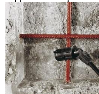
Figure 4.19 : Humidification des armatures
