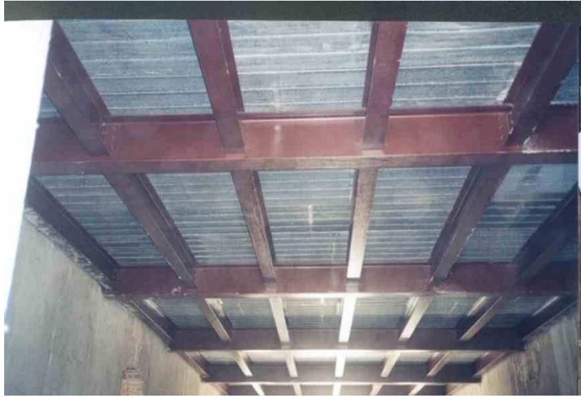
Figure 1.32 : Tôle nervurée métallique posée sur le quadrillage
