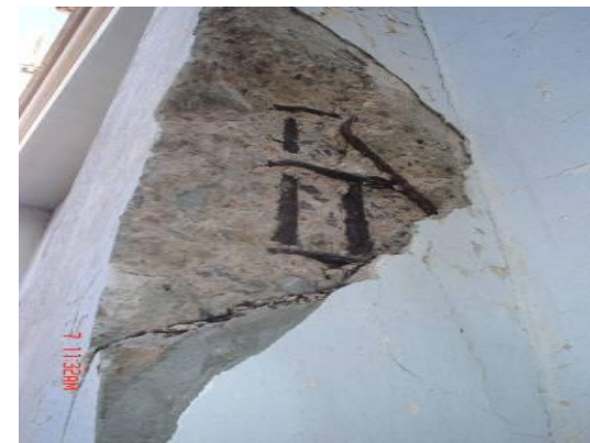
Figures 1.26 : Pathologies relevées sur le bâtiment
