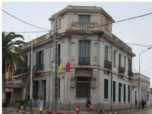
Figure 1.25 : Vue côté Nord du bâtiment de la banque nationale
