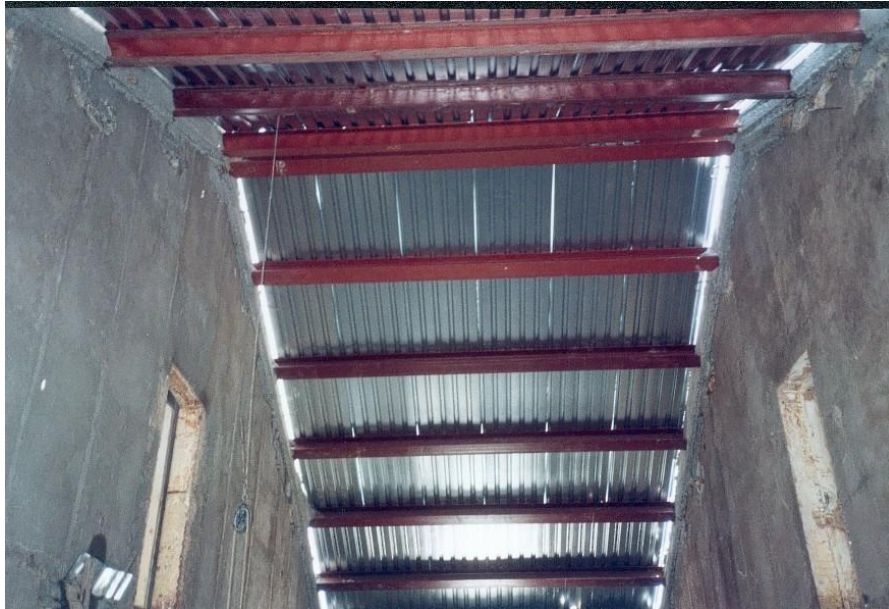
Figure 1.30 : Poutres principales ancrées aux murs porteurs
