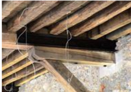
Figure 1.1 : Photo d'une poutre en bois renforcée avec de l'acier
