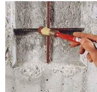
Figure 4.18 : Application du produit anticorrosion
