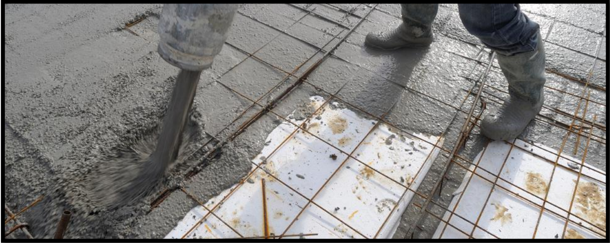
Photo 48: utilisation du béton au dallage
