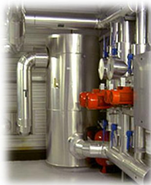
Photos 17: filtration d'air chimique 39
