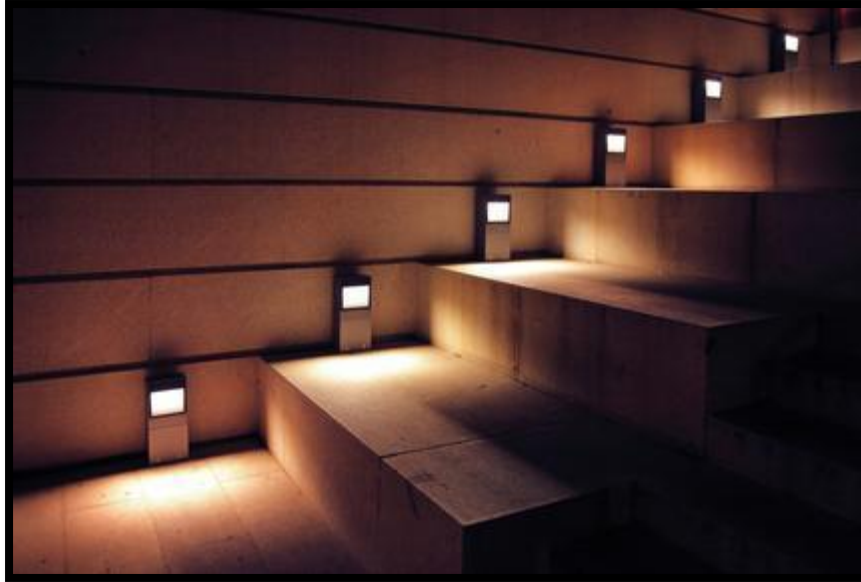
Photo52 : exemple d'éclairage artificiel
