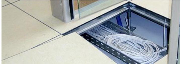
Photo68 : exemple d'un plancher technique
