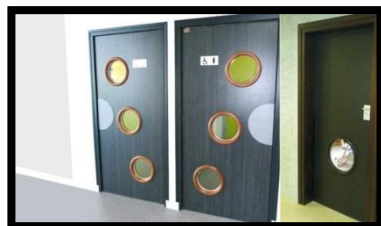
Photo58 : exemple d'une porte isotherme
