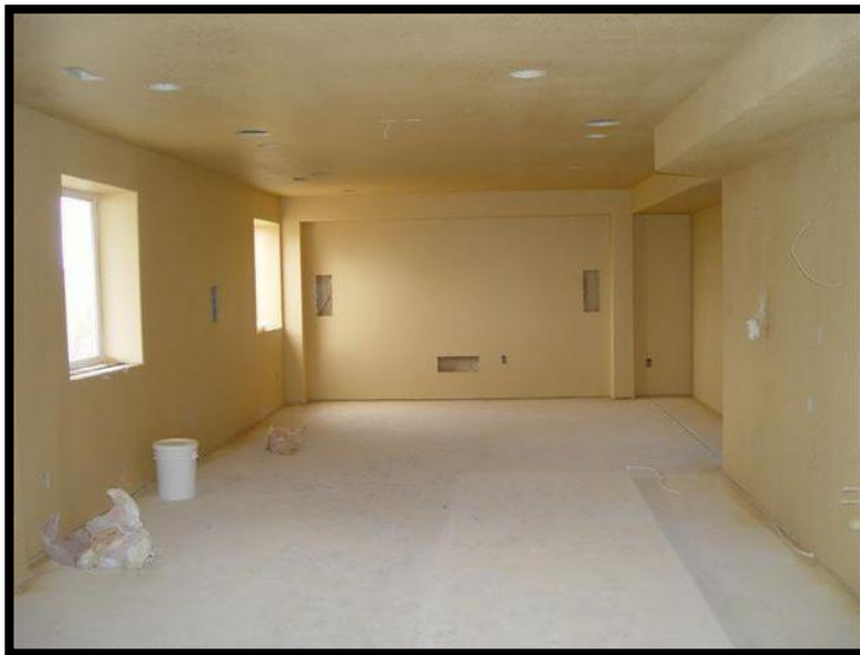
Photo63 : exemple de peinture intérieure d'un bâtiment
