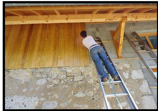
Photo65 : exemple du bardage en bois
