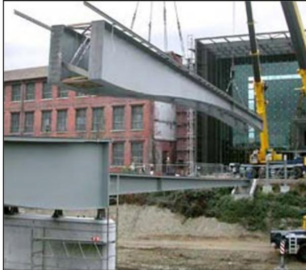
Figure 1.6 - Poutre à hauteur d'âme variable.
