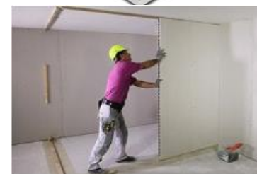
Fig. 199 : C.S à âme alvéolaire
