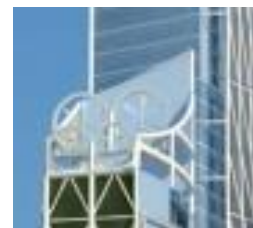
Fig. 239 : les 4 éoliennes du projet final
