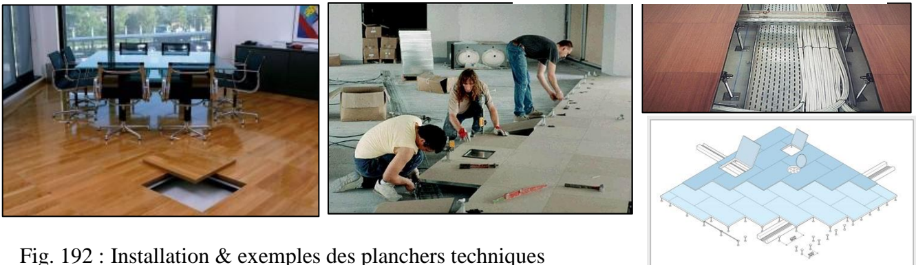
Fig. 191 : Composants planchers techniques
