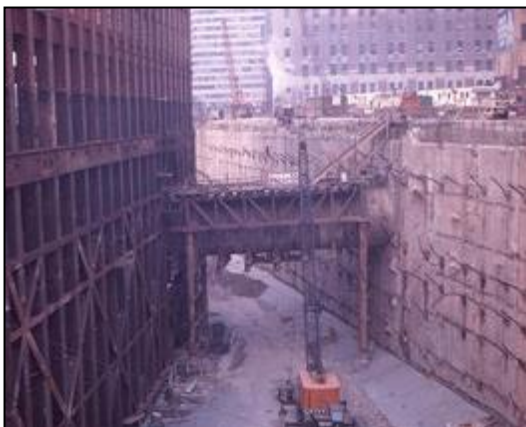
Fig. 6 : Fondations des tours jumelles à New York, photo prise en 1969
