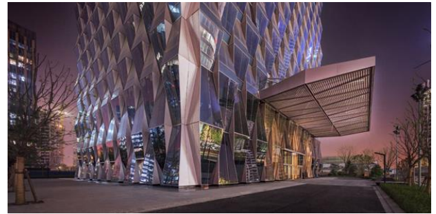
Fig.108: Tour de Pékin améliore son efficacité énergétique avec une façade en verre trapézoïdale
