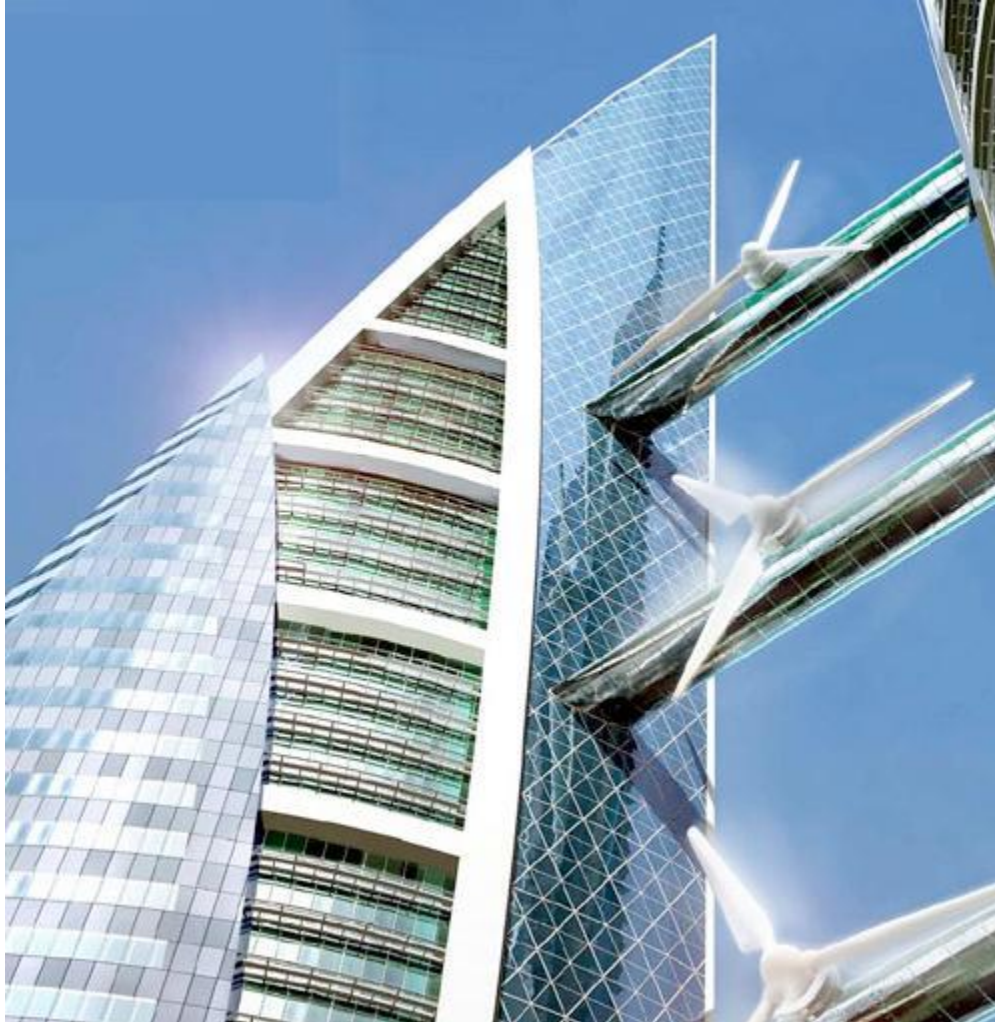
Fig.106 : panneaux photovoltaïques & Eoliennes entre les deux tours à Bahreïn 106
