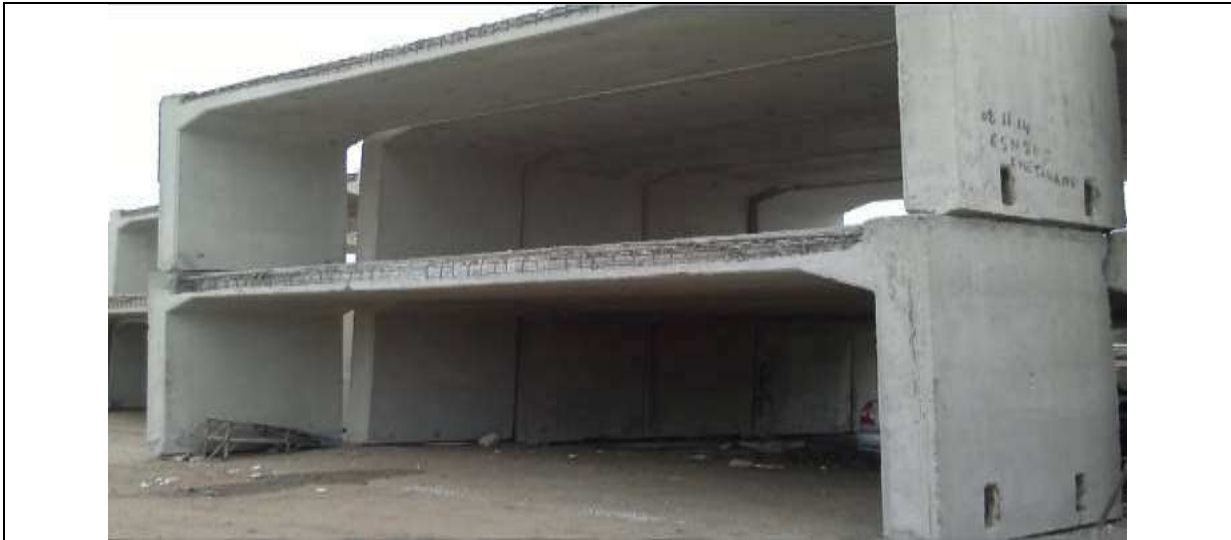
Figure 7 : Elément préfabriqué en « U » renversé
