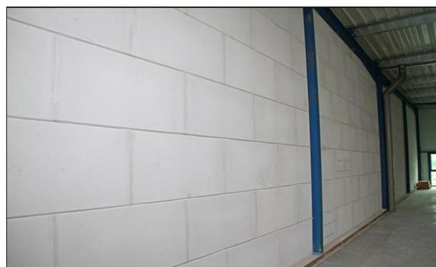
Figure 121 : mur en bloc de béton cellulaire<sup>128</sup>
