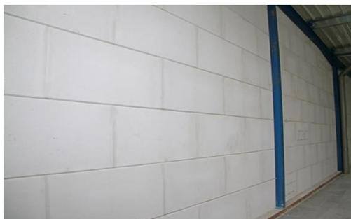
Figure 107: mur en blocs de béton cellulaire Cellumat<sup>113</sup>
