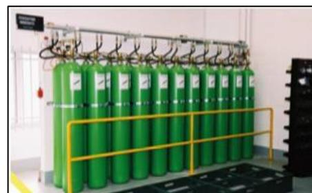
Figure 41 : bouteille de réserve de gaz inerte<sup>45</sup>
