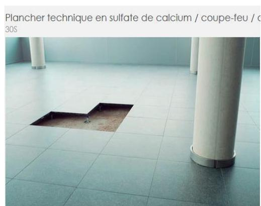
Figure131: plancher technique en sulfate de calcium<sup>140</sup>
