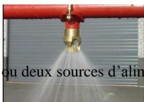
Figure 39 : sprinkler<sup>44</sup>
