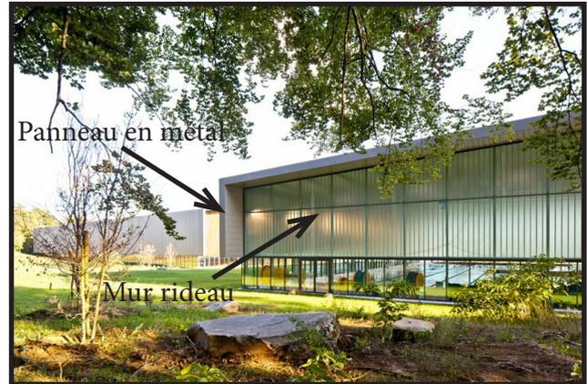
Figure (49) : Les différents matériaux utilisés dans le bloc de la piscine
