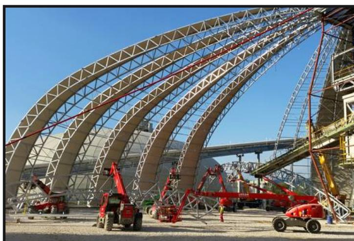
Figure (11): Photo qui montre des poteaux curvilignes en cours de construction
