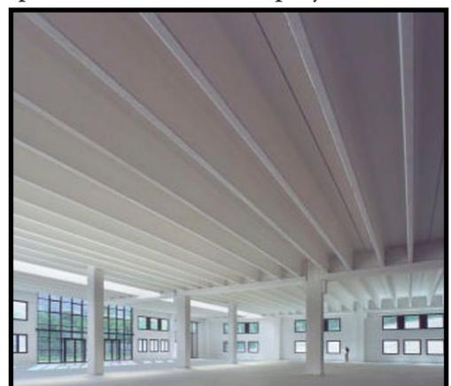
Figure (30): Halle de sport en plancher nervuré
