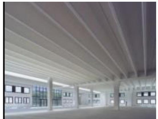
Figure 109 : dalle nervurée
