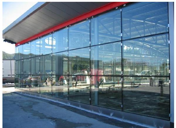
Le vitrage solaire est un **double vitrage** traditionnel à isolation renforcée qui dispose d'une couche isolante et de bandes de capteurs solaires intégrés.
