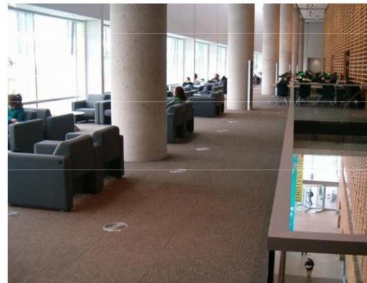
Figure164 :pièce avec un systeme de diffusion de type déplacement par le plancher
