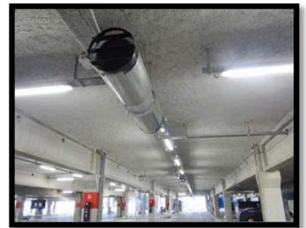
Figure 237 : Système d'optimisation des flux D'air dans les parcs de stationnement : Jetfan
