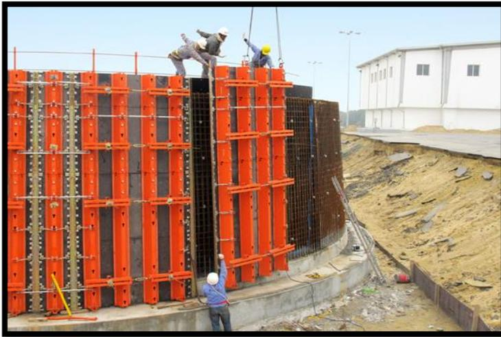
**Figure 161:** PASCHAL, Les panneaux de coffrage à rayon adaptable pour la réalisation du mur voile.
