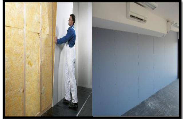
Figure 267 : séparation en cloison double parement
