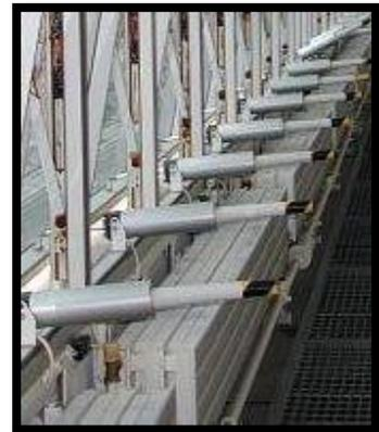
Figure 219 : Des vérins pour l'ouverture automatique
