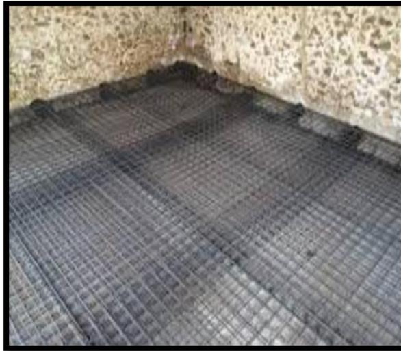
**Figure 160:** Illustration d'exécution d'un radier général
