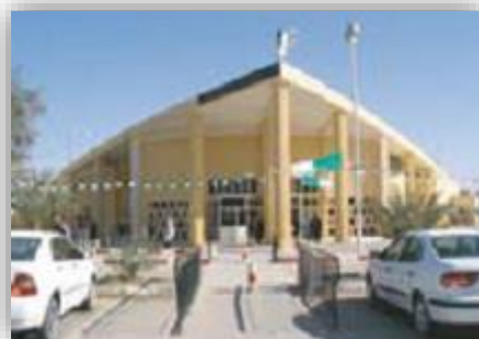
Figure 23. Vue de l'entrée principale de l'aéroport Ain Beida
