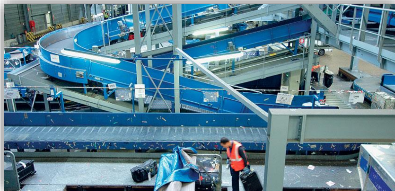
Figure 72. Salle de tri des bagages de l'aéroport Charles De Gaulle (Paris, France)
