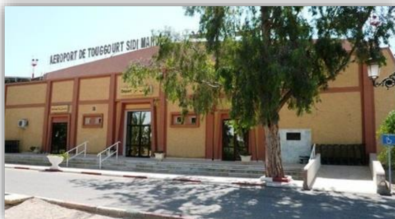
Figure 24. Vue de l’entrée principale de l’aéroport Sidi Mahdi
