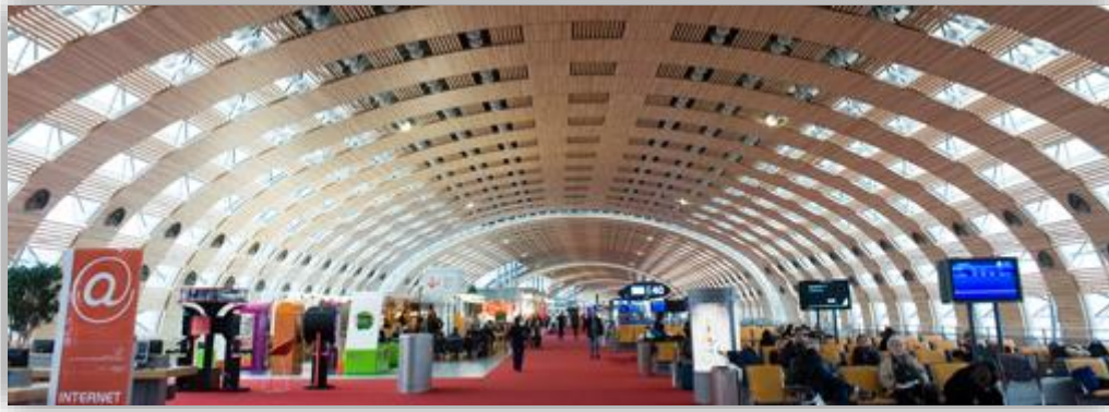
Figure 1. Vue intérieur de l'aéroport Roissy Charles De Gaulles (Paris, France)
