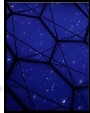
Figure 67: ETFE thermoplastique Figure 67: les nœuds tridimensionnels Figure 67: l'acier galvanisé Source: www.edenproject.com
