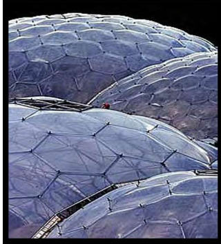
Figure 67: ETFE thermoplastique Figure 67: les nœuds tridimensionnels Figure 67: l'acier galvanisé Source: www.edenproject.com
