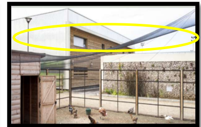
Les toitures sont composées de terrasses et de bardage Zinc
