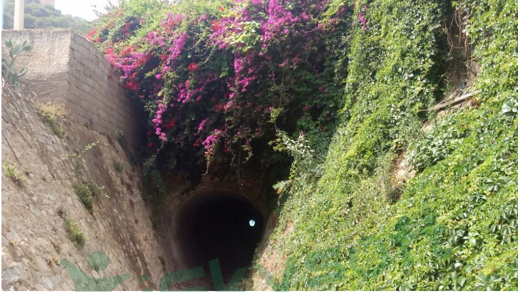
Photo 3-9: L'entrée du tunnel.
