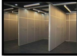
Figure 111. Cloisons mobiles en aluminium
