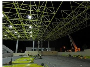
Figure 29. La charpente métallique en treillis de la salle de sport en Portugal
