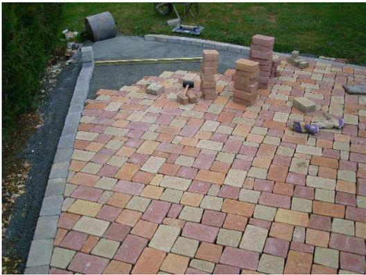
**Pavés vieillis posés à chant-dalle en béton**
