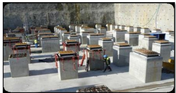
Figure 167: plot parasismique sur radier
