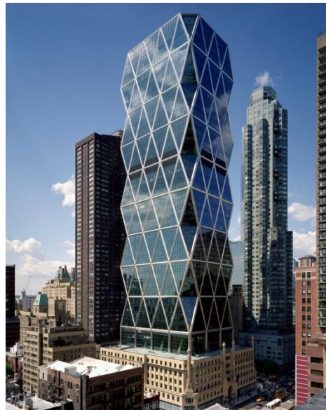
Façade de Hearst Tower
