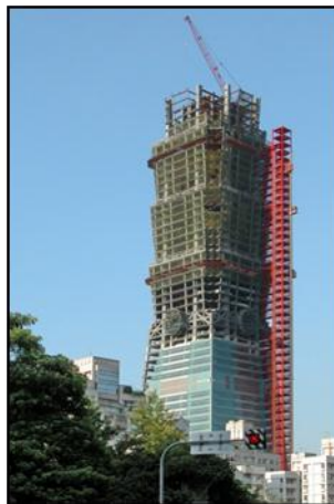
Figure 59 : construction de la tour
