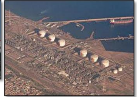
Figure 107 : Port de Bethioua : Port pétrolier du pays.
