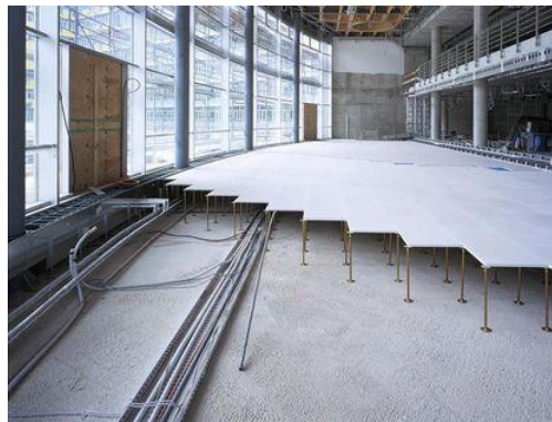
Figure 208 : exemple d'un plancher technique
