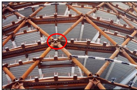
Figure 190 : Nœud du diagrid
