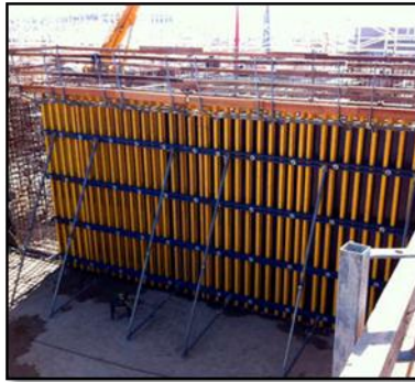
Figure 168 : coffrage d'un mur voile
