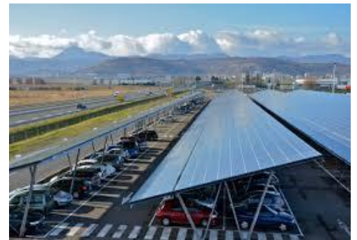
Figure 214 : Panneaux solaires thermiques au parking
