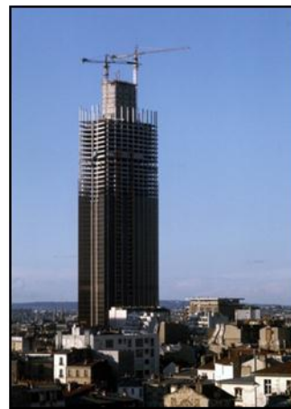
Figure 49 : La tour en cours de construction
