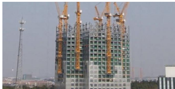
Tour en cour d'exécution en Chine
