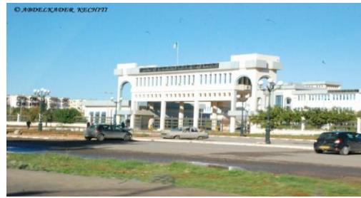
Figure 111 : Hôpital 1 er novembre
