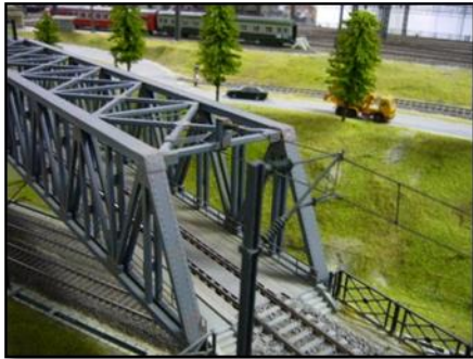
Figure 177: Poutre métallique en treillis
