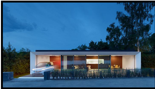
Figure 6 : Maison "zero energy" Stuttgart en Allemagne
