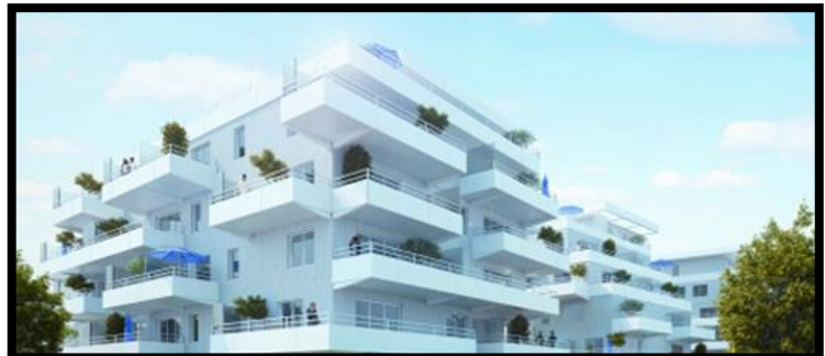
Figure 7 : maison Le premier bâtiment labellisé Bepos en France
