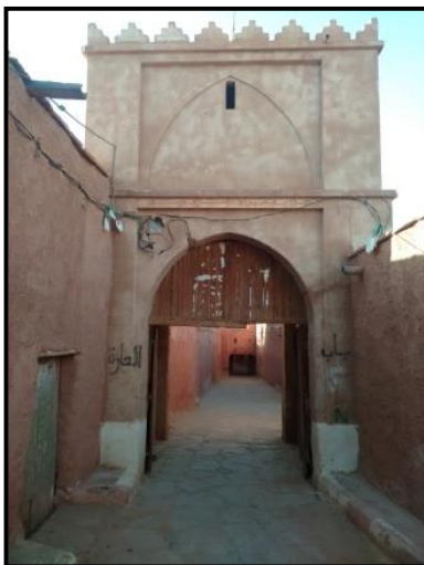
Figure 114 : entrée de ksar de Tiout
